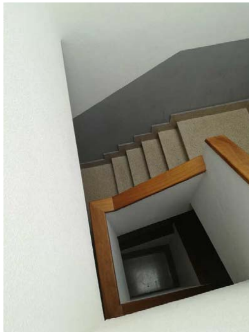
VISTA INTERIOR - ESCALERA DEL EDIFICIO
