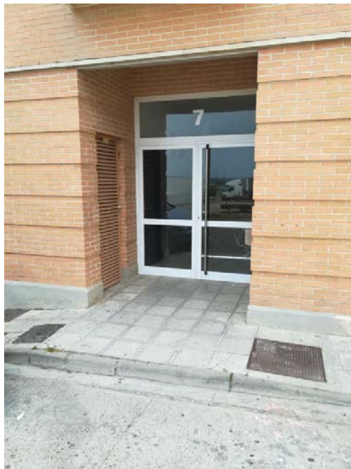
VISTA EXTERIOR DEL INMUEBLE - PORTAL
