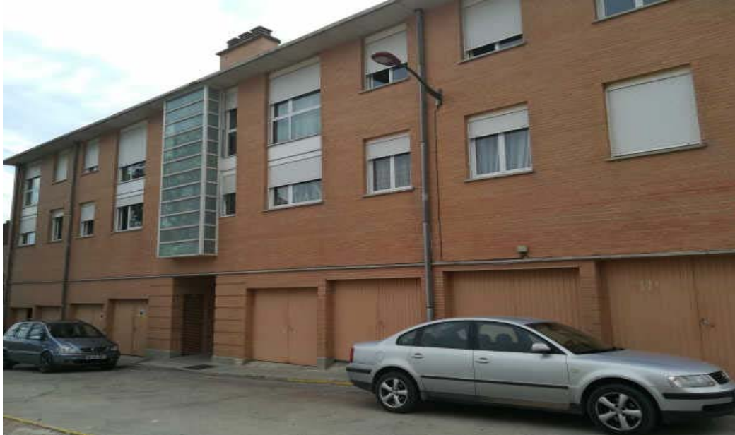
VISTA EXTERIOR DEL INMUEBLE - FACHADA
