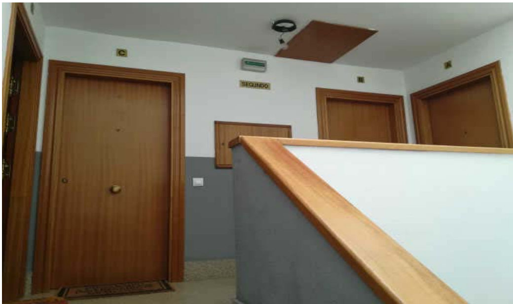
VISTA INTERIOR - RELLANO DE PLANTA SEGUNDA
