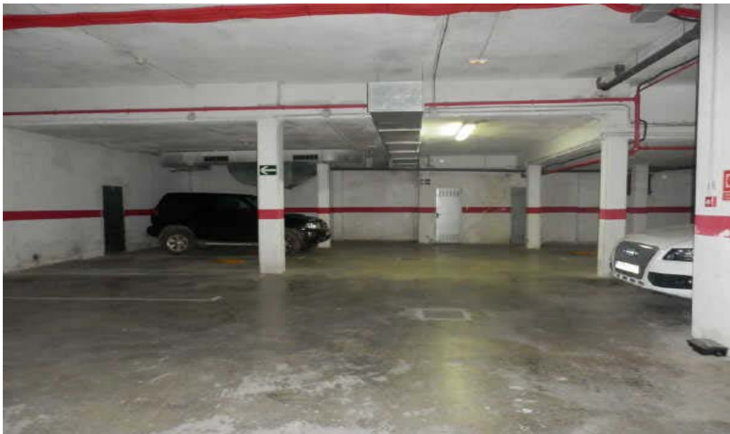
VISTA INTERIOR DEL INMUEBLE - GARAJE
