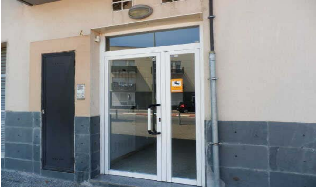
VISTA EXTERIOR DEL INMUEBLE - PORTAL
