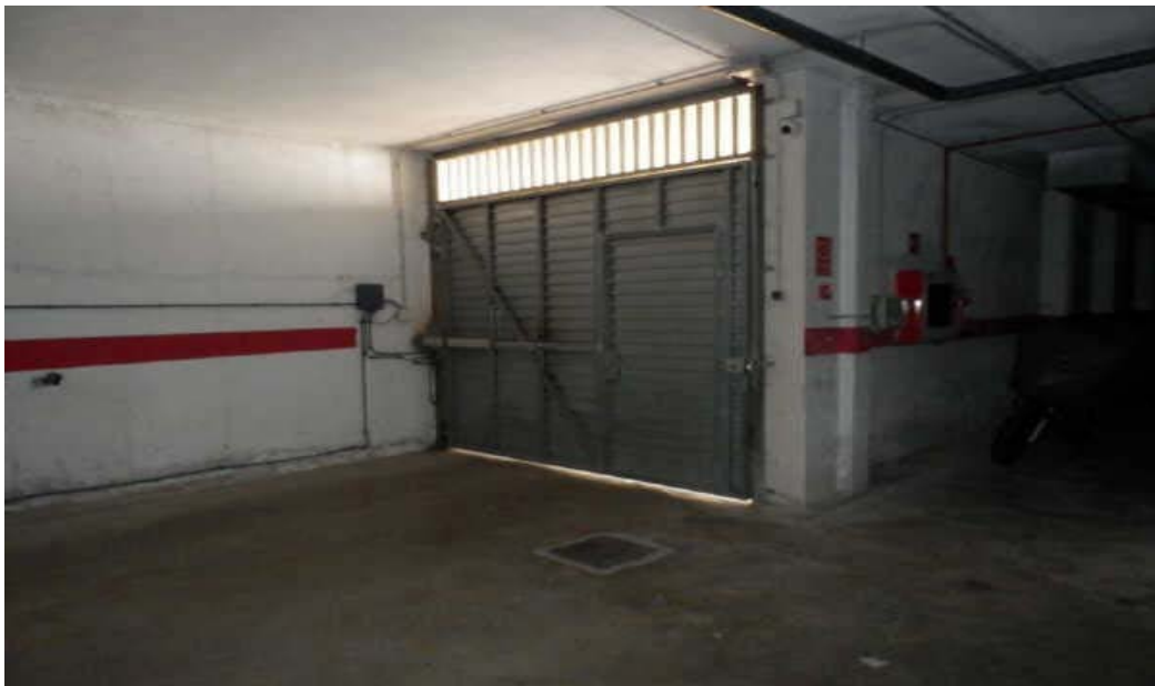
VISTA INTERIOR DEL INMUEBLE - GARAJE
