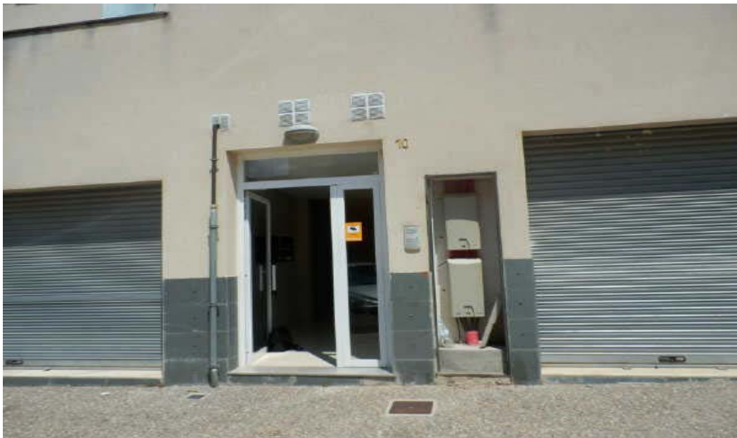
VISTA EXTERIOR DEL INMUEBLE - PORTAL
