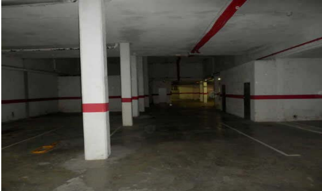
VISTA INTERIOR DEL INMUEBLE - GARAJE
